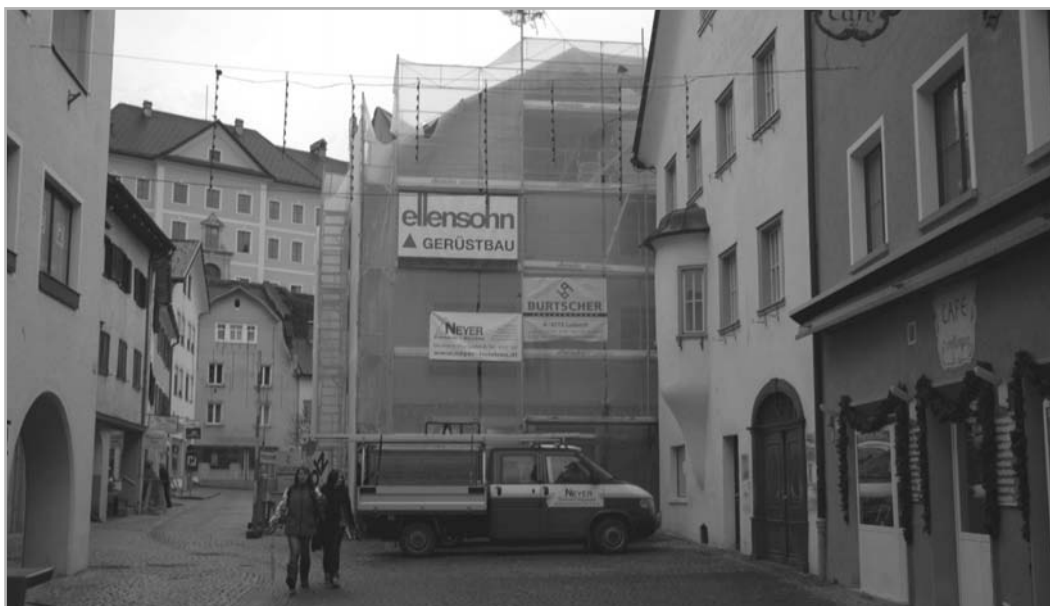
Geschäftshaussanierung: der neue Friseur "patrik" und der Jeans-Shop "a.store" beleben die Rathausgasse.
