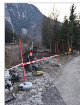
Am Lückenschluss der Beleuchtung des Radweges zwischen Brunnenfeld und Bings wird derzeit gearbeitet.
