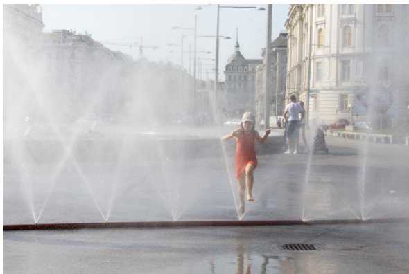
Abbildung 4: Sprühnebelanlage in Wien Quelle: Christian Fischer, 2021
